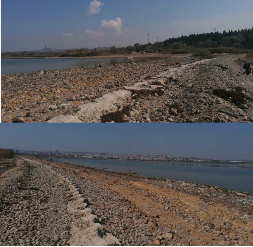
Şekil 3-4. Antik Baraj seti kalıntıları ve setten koparak göl kıyısına düşen yapı taşları
