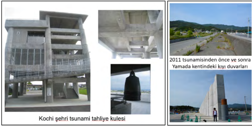
Şekil 1. Japonya'nın çeşitli kıyı kentlerinde tsunami hasarı azaltma çalışmaları çerçevesinde inşa edilen yapılar: Kochi kentindeki tsunami tahliye kulesi ve Yamada kentindeki kıyı duvarları
