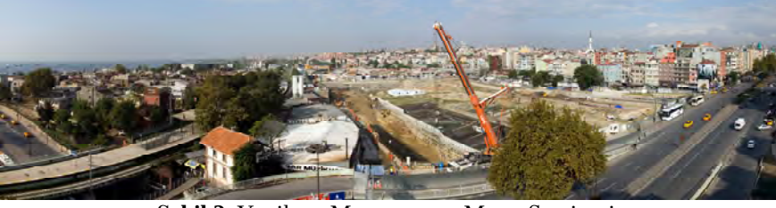
Şekil 2. Yenikapı Marmaray ve Metro Şantiyesi.
