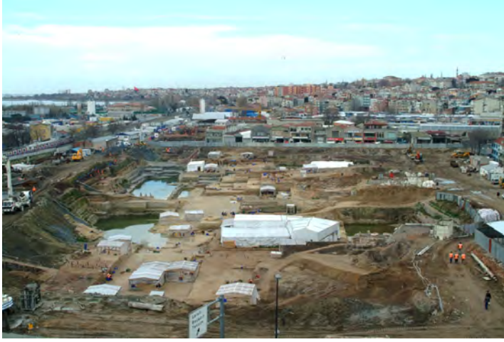
Şekil 1. Yenikapı Metro ve Marmaray kazı alanının görünüşü.
